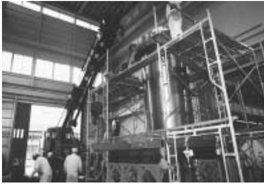
組立風景 ラフテレーンクレーンを使っでの組立作業
